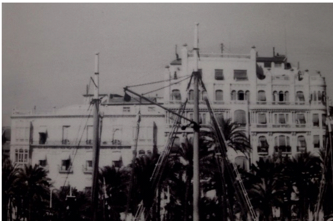
Imagen fotográfica del frente marítimo en torno al año 1950, donde puede apreciarse la construcción existente en el ático ( Alicante en Blanco y Negro. Recuerdos de la Ciudad y el Mar. Ediciones Tívoli)
