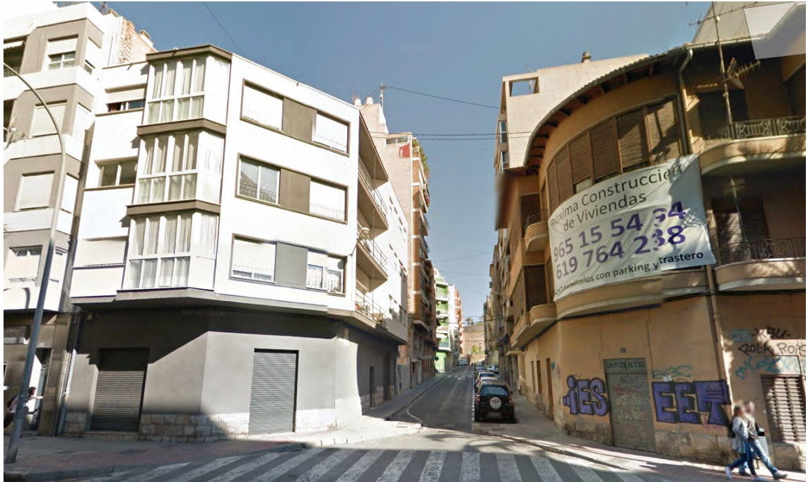
Acceso a la calle Jose M a Pi, desde el frente de la Avda. Benito Pérez Galdós
