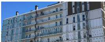
9. Galería con vuelo de forjado con cubierta sobre el mismo:
