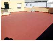
5. Balcón sin vuelo de forjado con techo cubierto:
