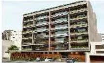
6. Balcón con vuelo de forjado con cubierta sobre el mismo:
