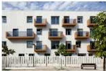
8. Galería sin vuelo de forjado con techo cubierto:
