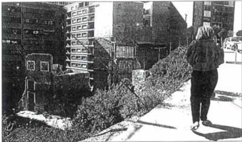
En pleno centro de Alicante un transformador de energía eléctrica es lo que queda del derribo de cuatro fincas
