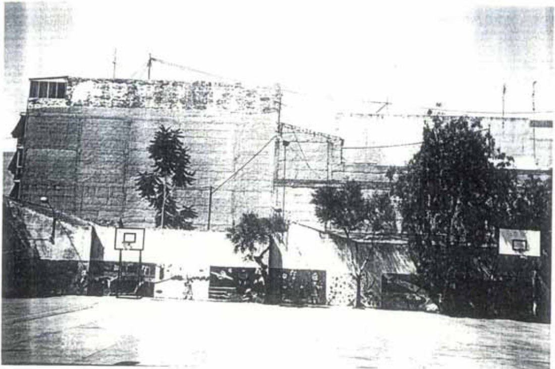
MEDIANERIAS ACTUALES VISTAS DESDE PATIO COLEGIO
