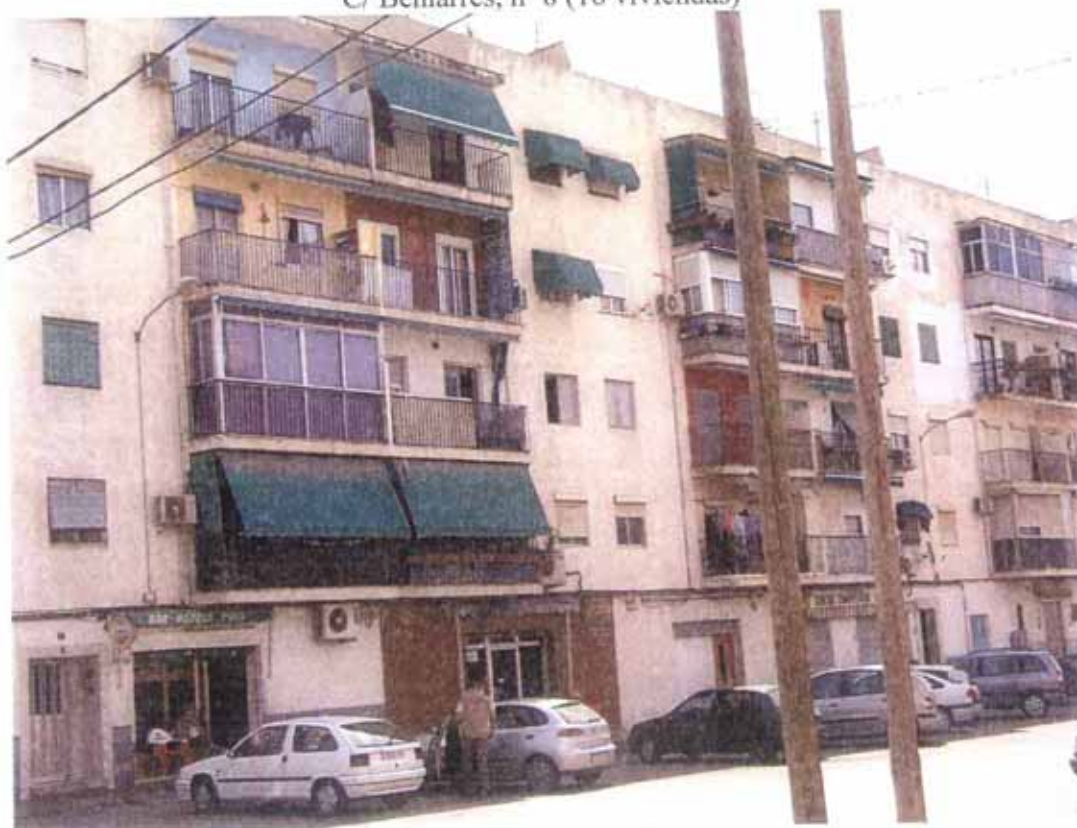
BLOQUE III y II C/ Beniarres, nº 8 (16 viviendas) y nº 6 (16 viviendas)
