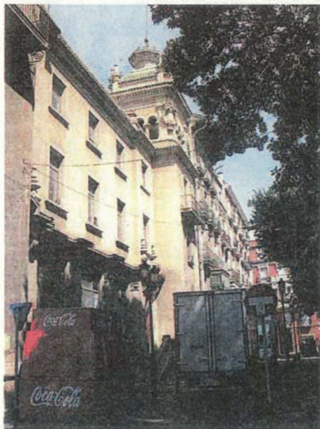
EDIFICIO DE CORREOS
