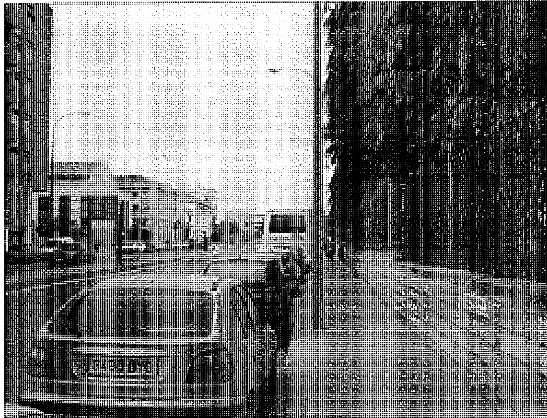
FOTO N° 1- Vista cerramiento Avda. Aguilera.
