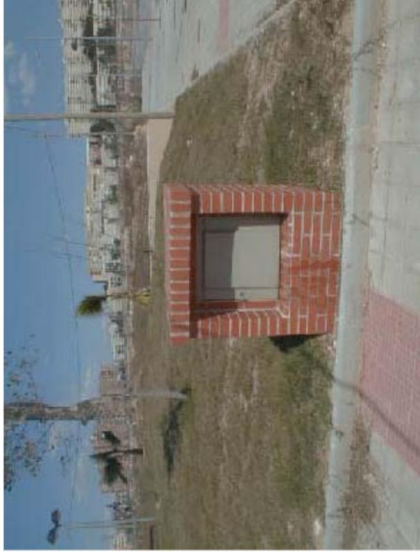
NOTA.- LAS DIMENSIONES DEL ARMARIO DE OBRA SE MODIFICARÁN EN CADA CASO SEGÚN EL TAMAÑO DEL ARMARIO HIMEL UTILIZADO
