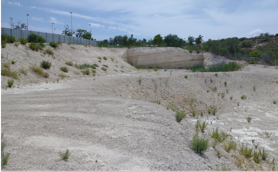
Figura 12. Vista panorámica del nivel inferior de la parcela UT-1 y de los taludes que la conforman. Al fondo, se aprecia un talud vertical ubicado en el extremo Sur de la parcela UT-1 en el que se aprecia la secuencia sedimentaria característica del tránsito Mioceno superior-Plioceno inferior del entorno de Agua Amarga y la Ciudad de la Luz.
