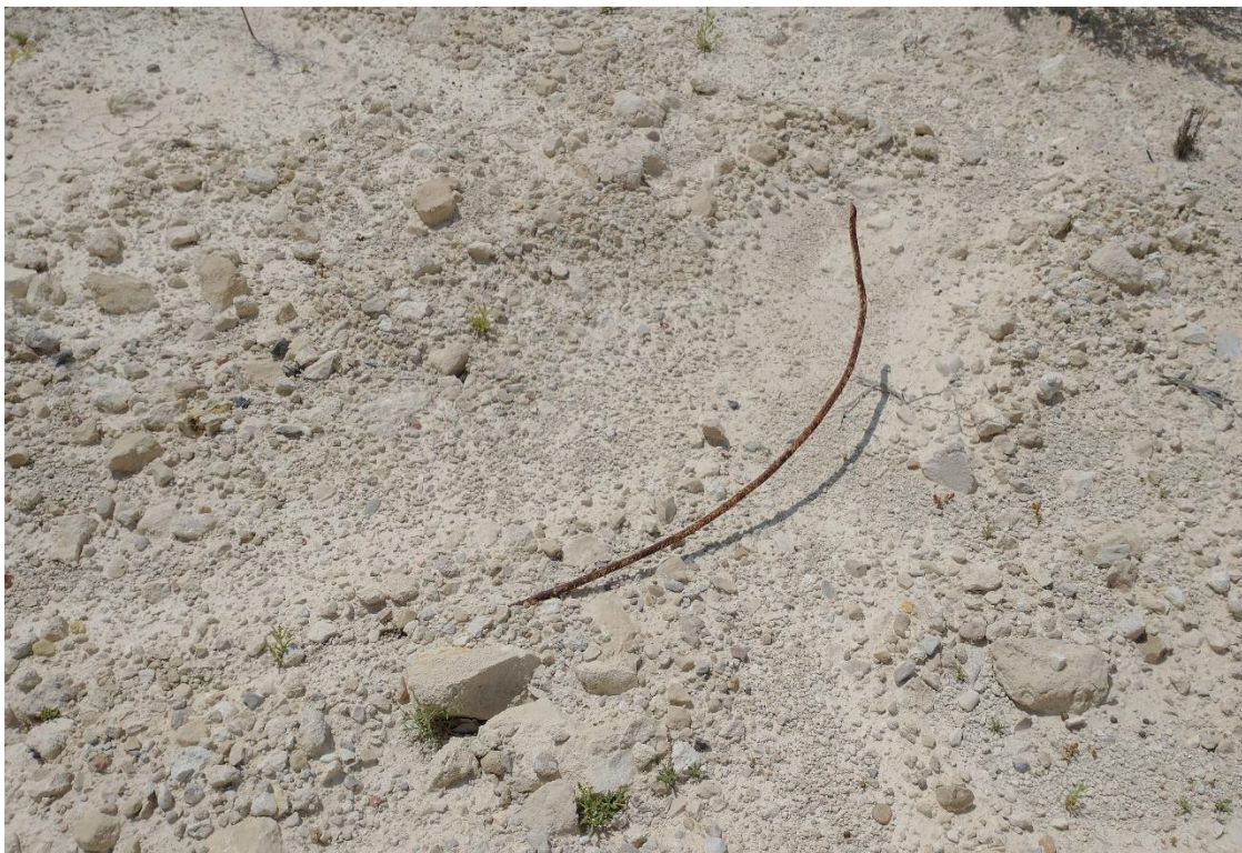
Figura 15. Los restos de las cimentaciones y encofrados de hormigón son las únicas evidencias que quedan en la parcela del complejo de apartamentos derruido.
