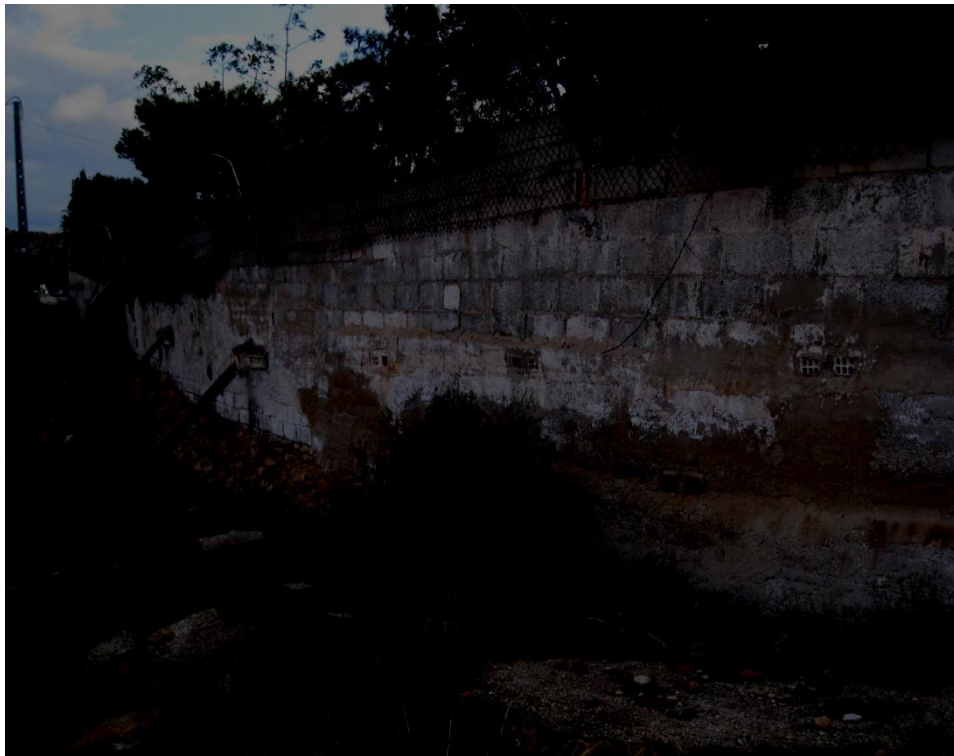
Foto 1.- Valla de 2,70 m. alto.
