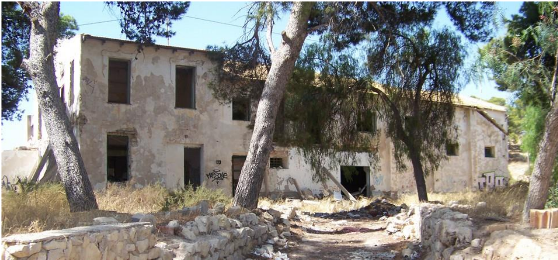
Foto 1.- Vista fachada principal.
