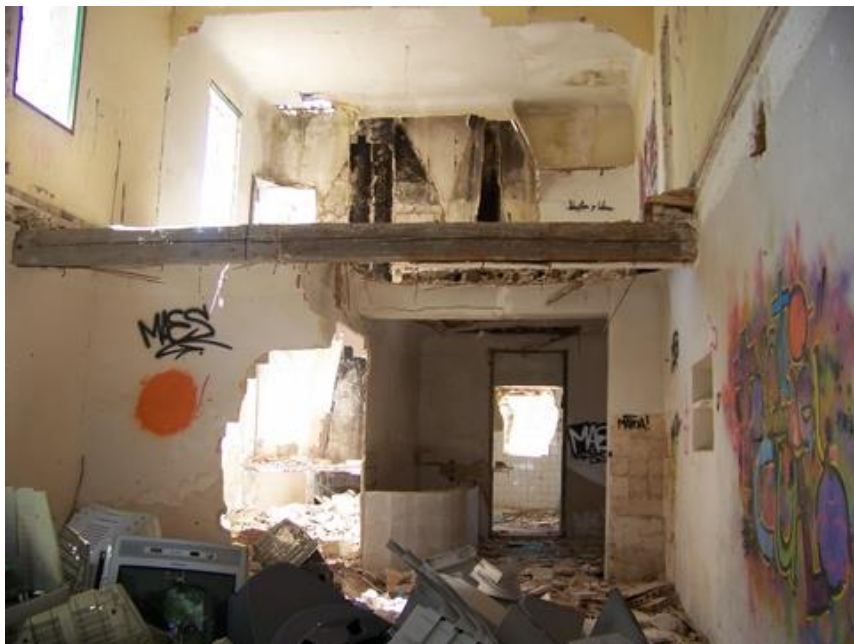
Foto 3.- Interior de la vivienda.
