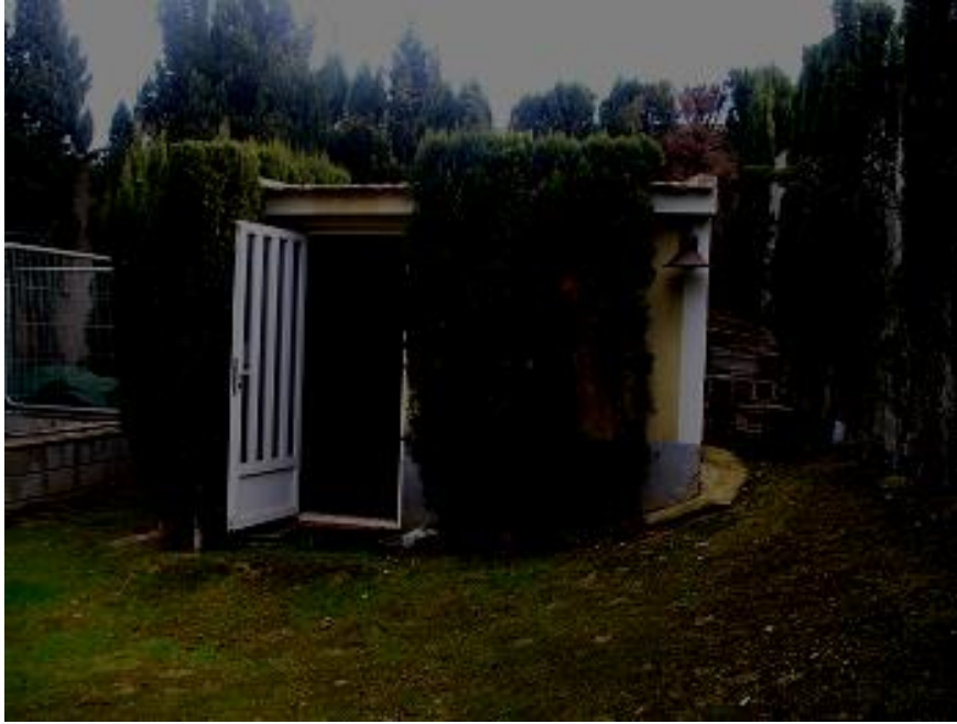
Foto 3.- Caseta equipo centralización riego.
