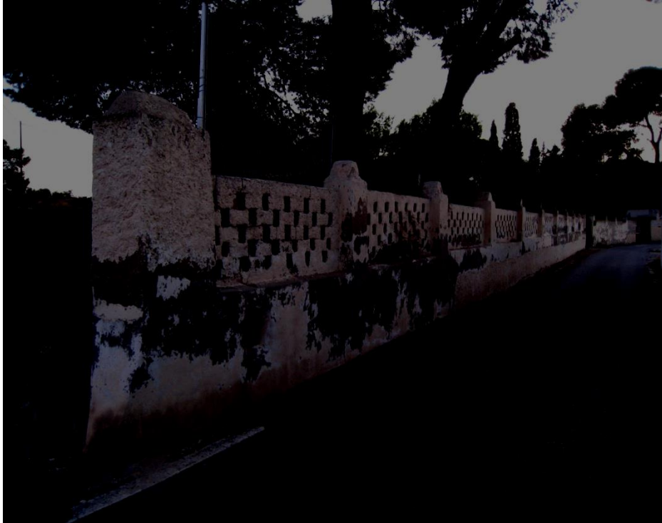
Foto 1.- Vallado de fachada.
