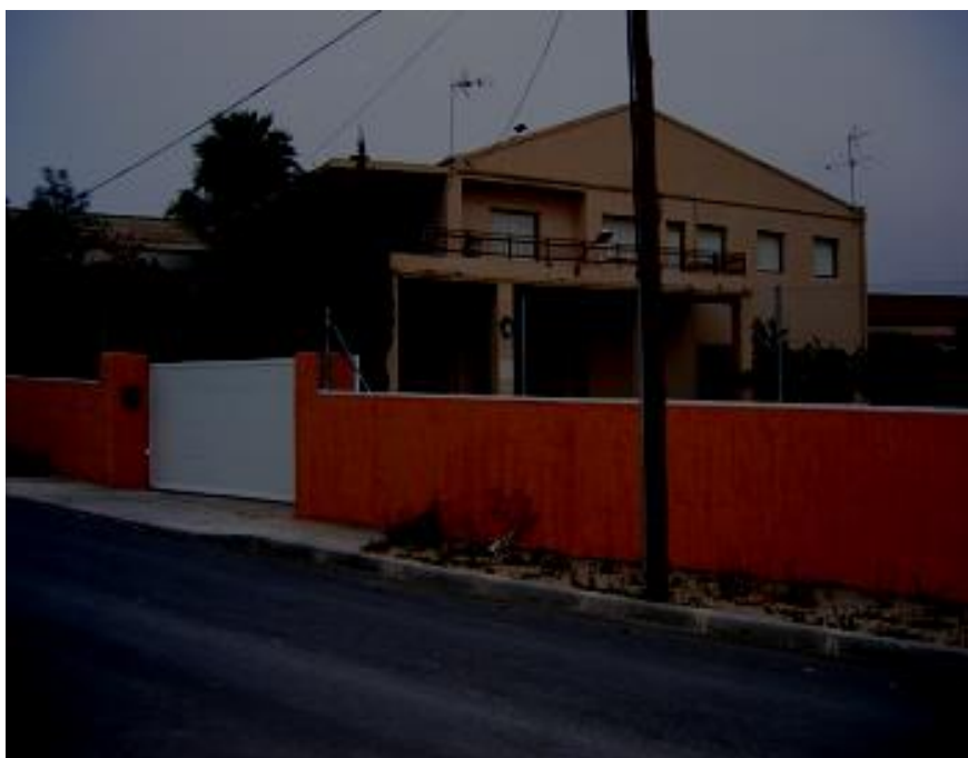
Foto 1.- Vallado de fachada
