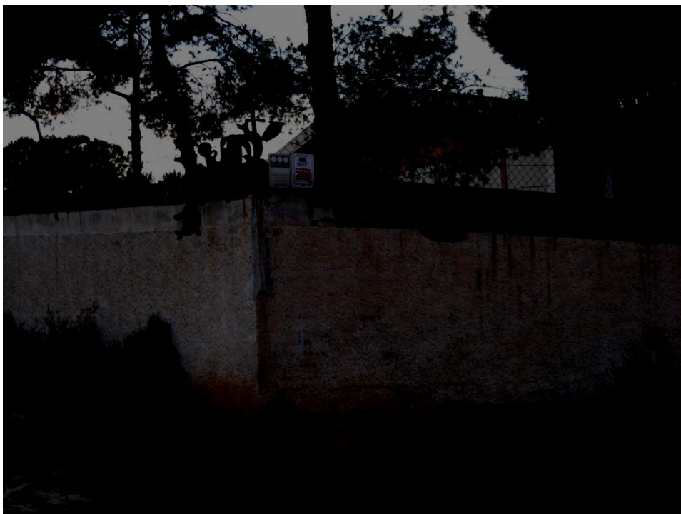
Foto 2.- Valla de 2,00 m. alto.
