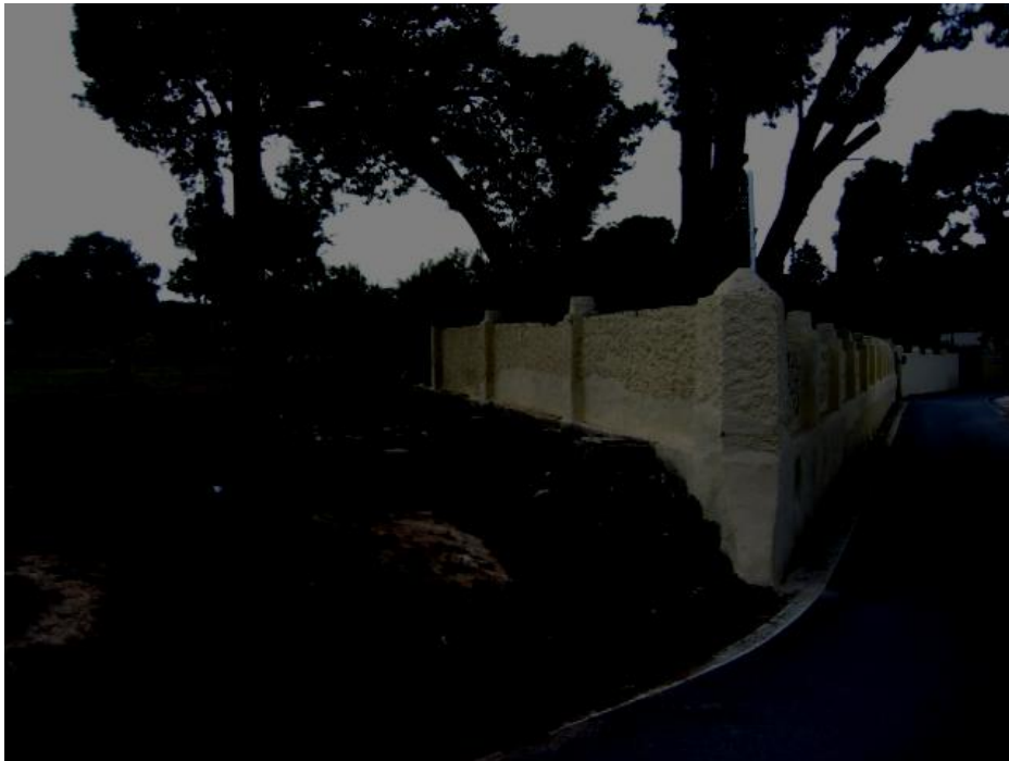
Foto 3.- vista general de zona afectada.
