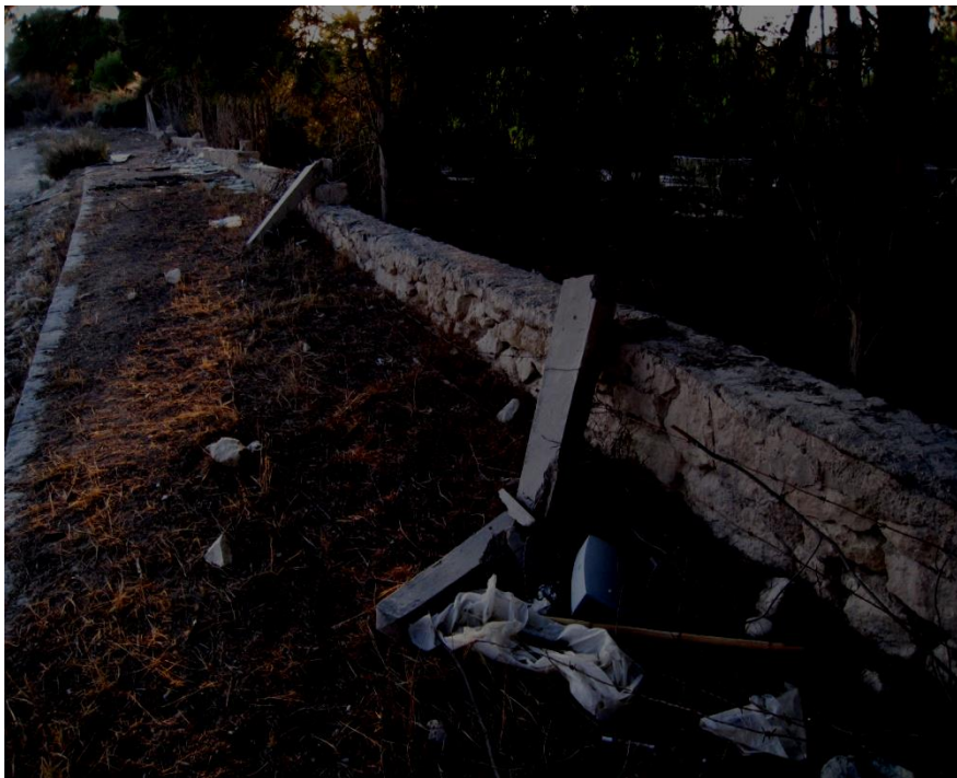
Foto 3.- Muro de mampostería ordinaria (sin postes de coronación).
