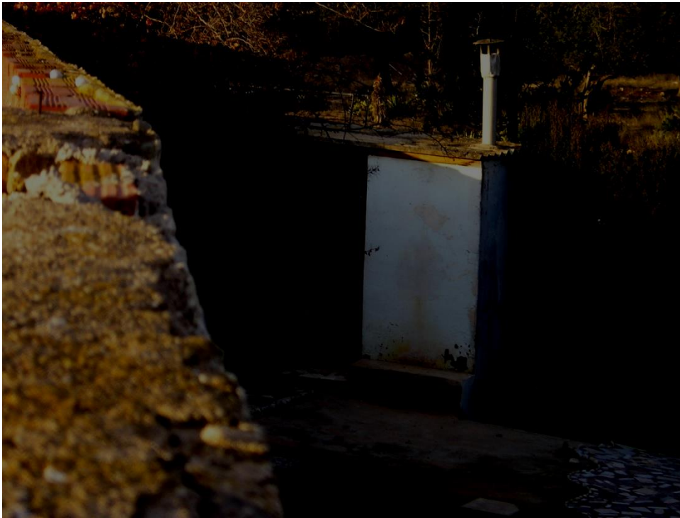
Foto3.- Vista anexo de cocina o barbacoa.
