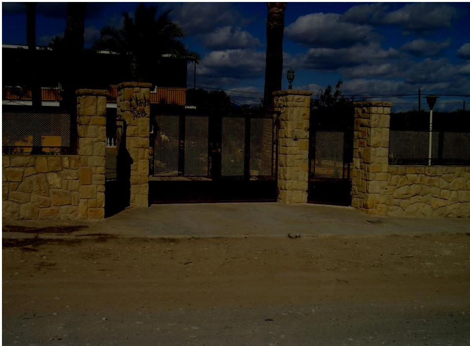
Foto 1.- Vista vallado en fachada.
