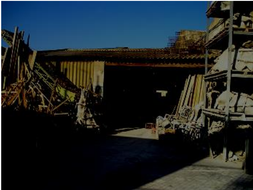
Foto 3.- Parte trasera de la nave, vista desde el patio.
