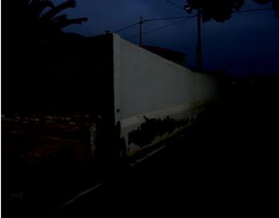
Foto 3.- Vallado de fachada.
