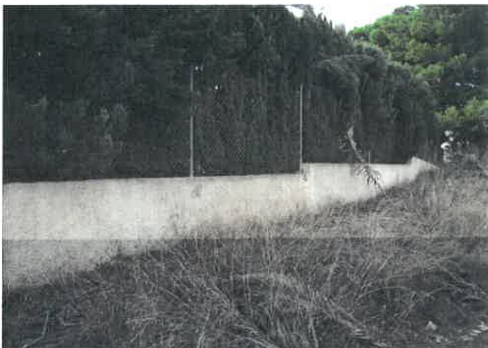
Foto 4.- Vallado de 0,80 m. altura media, con alambrada.
