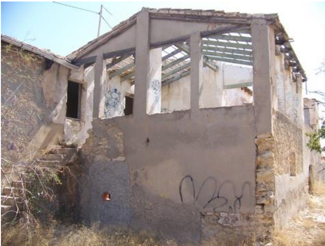
Foto 2.- Anexo de la vivienda.
