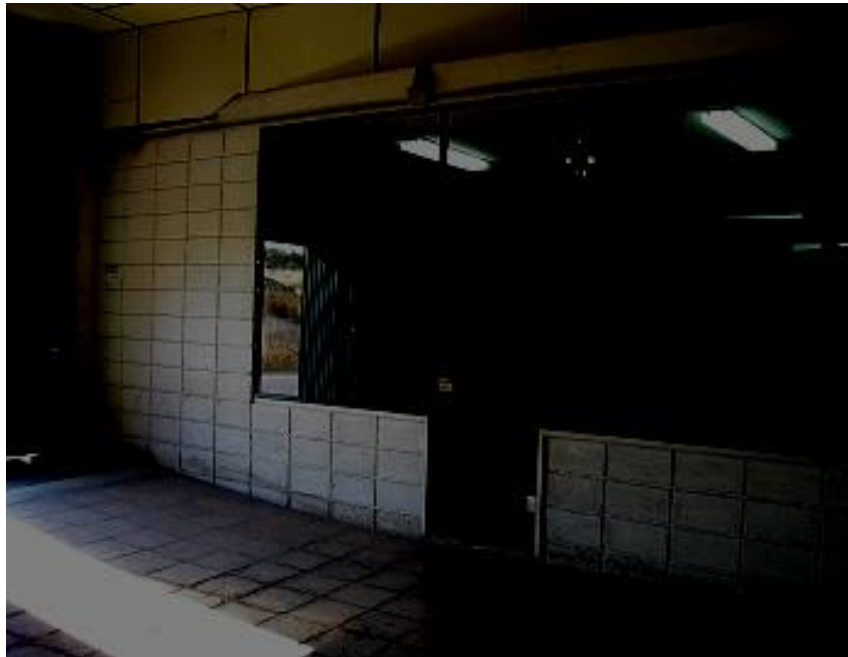
Foto 3.- Zona de oficinas.
