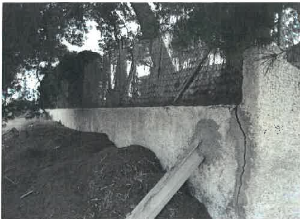
Foto 3.- Vallado de 0,80 m. con apuntalamiento.
