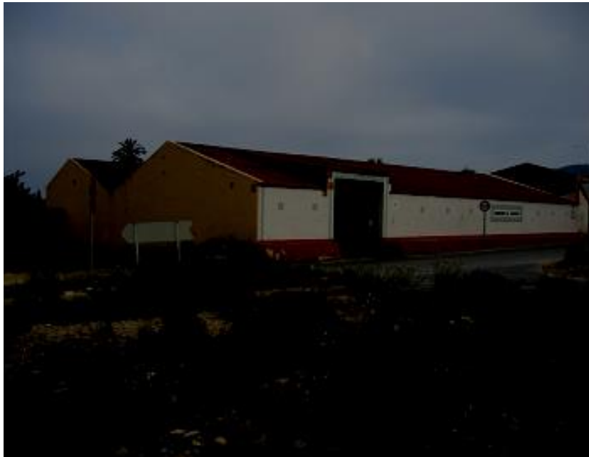
Foto 1.- Vista general de la nave.
