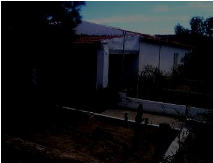
Foto 2: Vista general vivienda y anexo.
